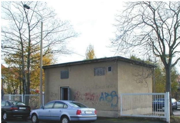
Trafostation 2003 vor dem Umbau
